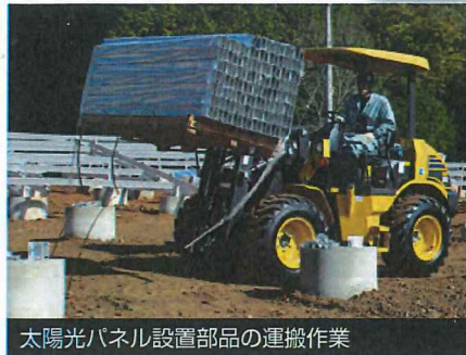
太陽光パネル設置部品の運搬作業
